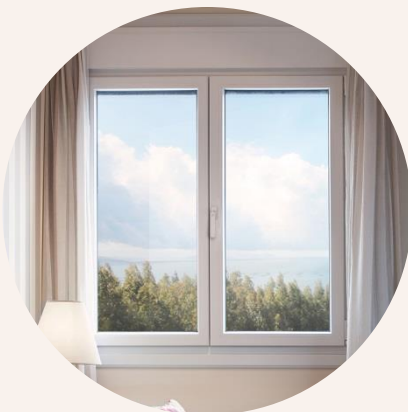
Ventanas Envolvente del edificio.
